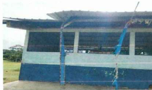
Foto 2: Se observa la estructura portante en mal estado del modulo 1.
